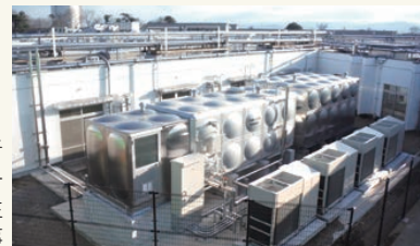
県立障害者リハビリテーションセンター新棟建設給排水衛生設備工事
