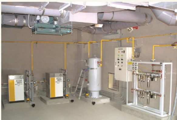
群馬大学第一種感染症病棟改修機械設備工事
